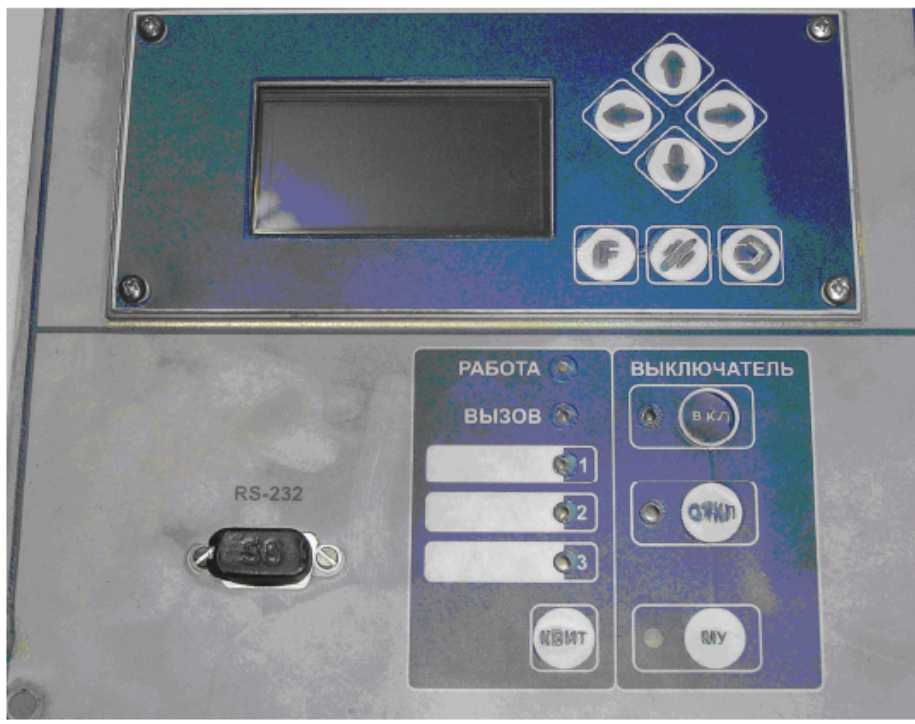
Рисунок 52 Следы продуктов горения на корпусе блока
